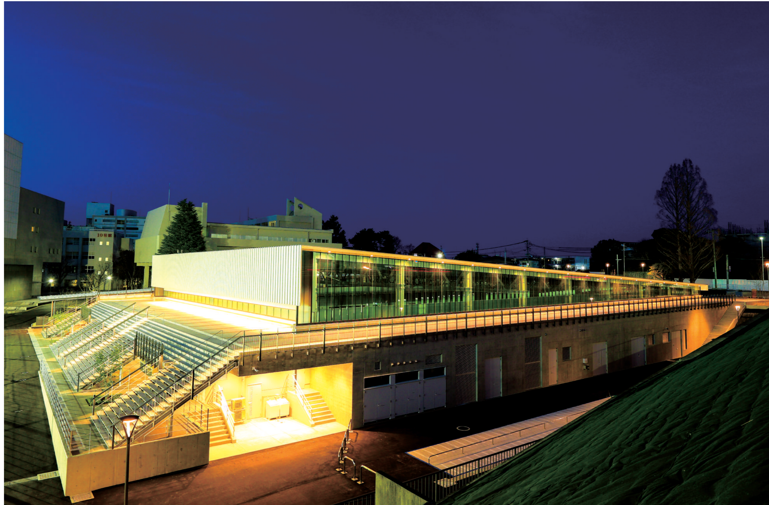
2021年2月竣工のプール。日本水泳連盟から公認を受け、国際競技も開催可能。西側にはサッカー観戦用のスタンドを備える、新たなスポーツ文化創出の拠点。
